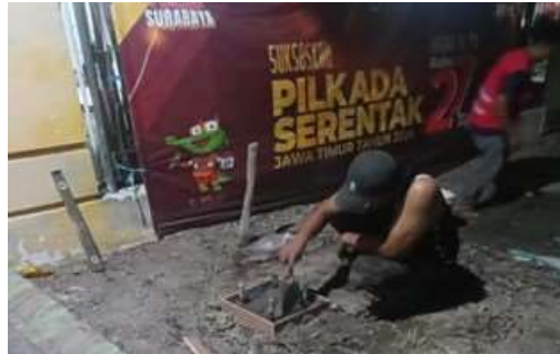
Gambar 4. Pembuatan dudukan tiang
