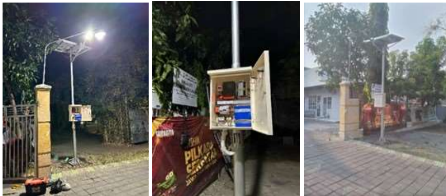
Gambar 5. Pemasangan dan instalasi PDU
