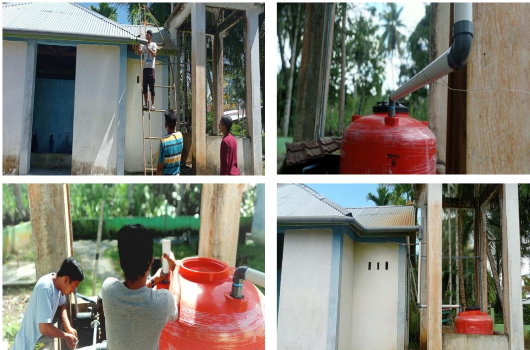
Gambar 11. Pemasangan instalasi PAH oleh Mitra pengabdian
